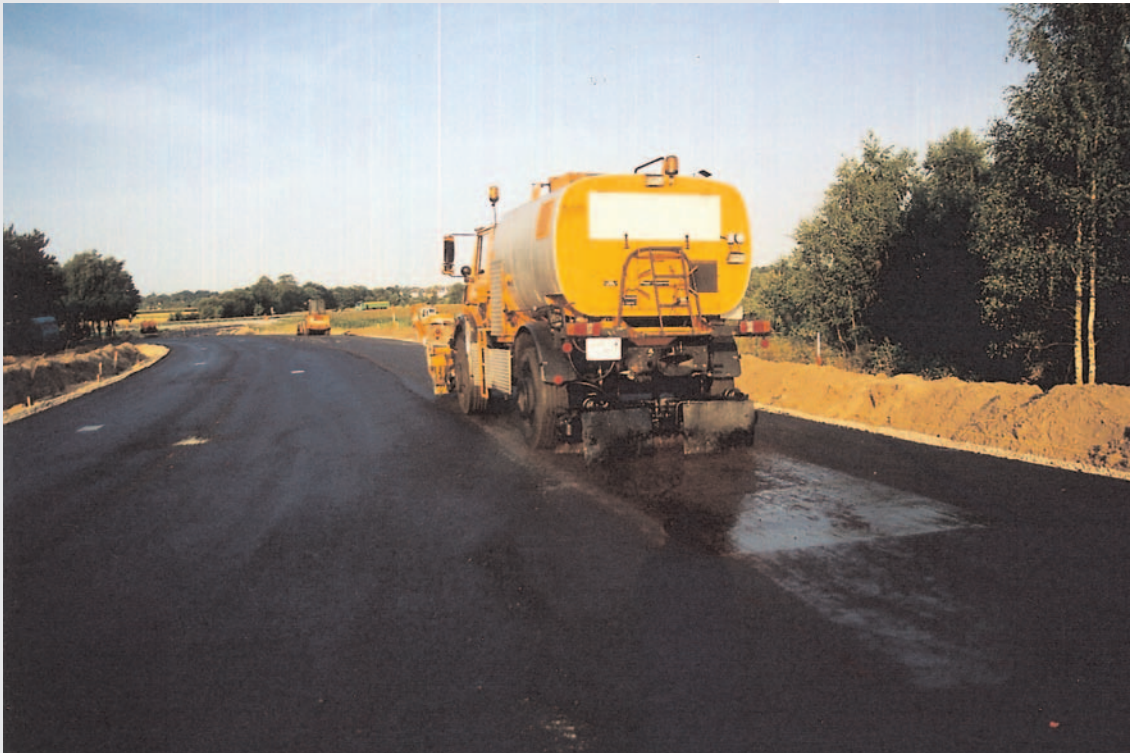
Bild 1: Ansprühen von Bitumenemulsion mit dem Rampenspritzgerät
