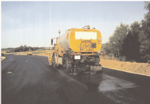
Anspritzen von Bitumenemulsion mit dem Rampenspritzgerät
