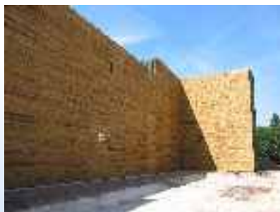
Fertig verschaltete Wandfläche
