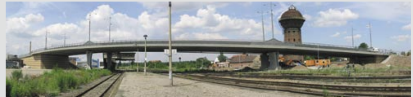
Seitenansicht BW 2 - Neue Wehrstedter Brücke
