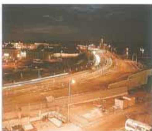
Die fertige Brücke
