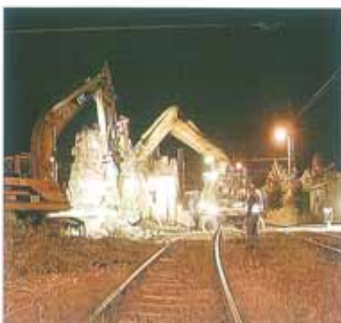
Allgemeine Baufeldansicht bei Tag und bei Nacht
