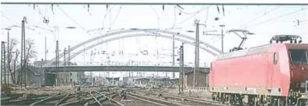
Fertiggestellte Brücke im Mai 2003
