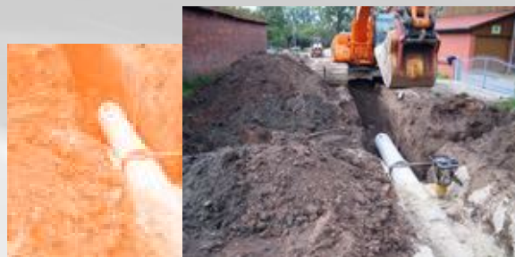
Verlegung des Regenwasserkanals
