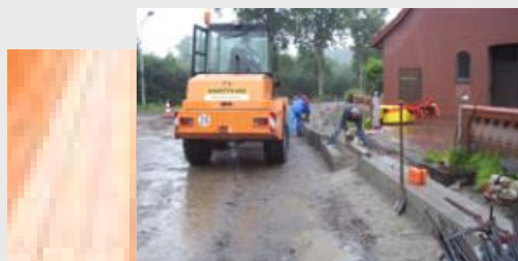
Anlegen der Gossenanlage
